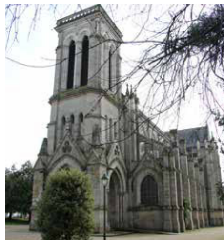
Pontivy, église Saint-Joseph L'église est construite entre 1863 et 1867 grâce à Napoléon III, qui prend sur sa cassette personnelle.
